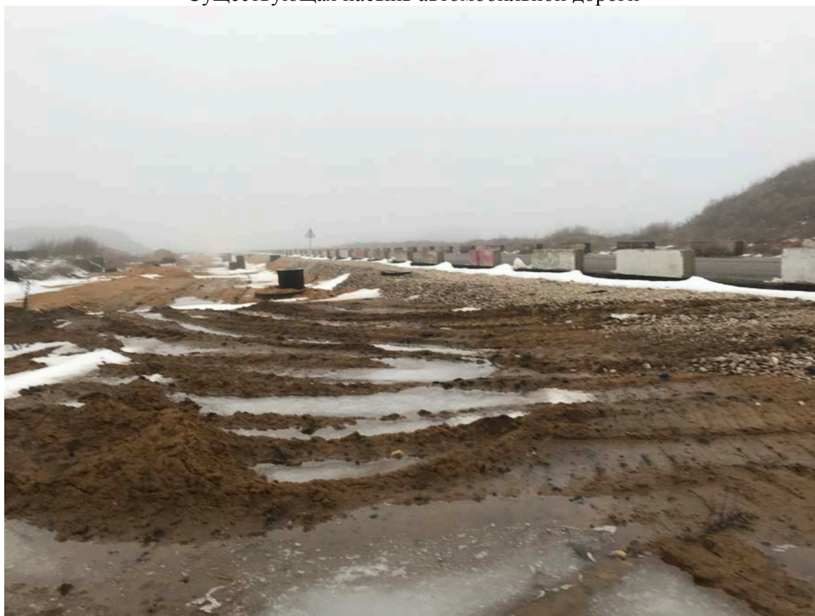
Существующая насыпь автомобильной дороги
