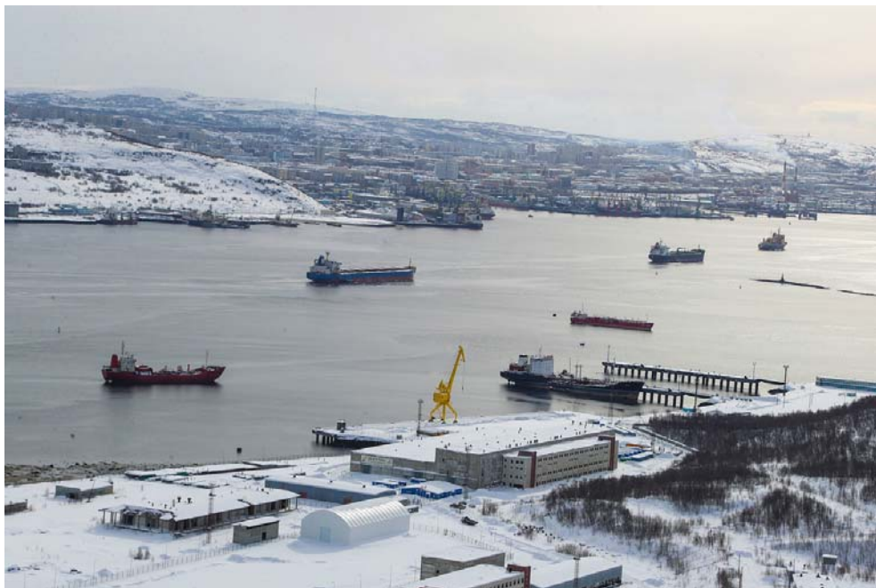
Рисунок 7. Район работ (причал ББО «Лавна»)
