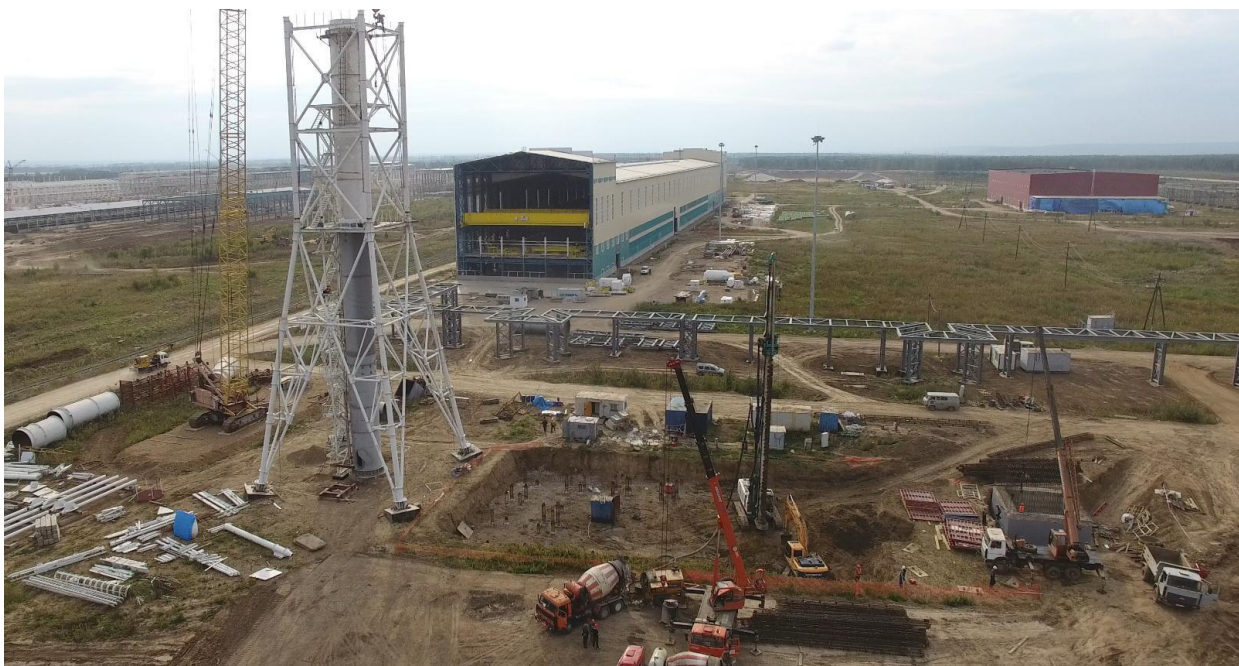
Рисунок 1.1-2. Реализация первого этапа строительства Тайшетской Анодной фабрики. Строительство газоочистной установки печей обжига анодов
