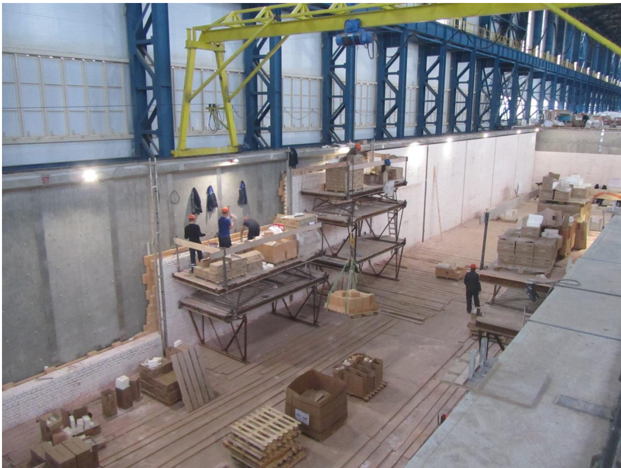
Рисунок 1.1-3. Реализация первого этапа строительства Тайшетской Анодной фабрики. Печь обжига анодов № 1, производство футеровочных работ
