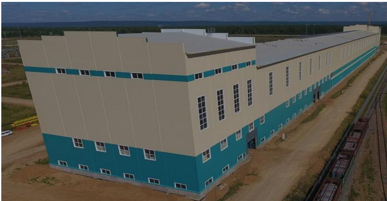
Рисунок 1.1-1. Реализация первого этапа строительства Тайшетской Анодной фабрики. Корпус обжига анодов № 1 (общий вид)
