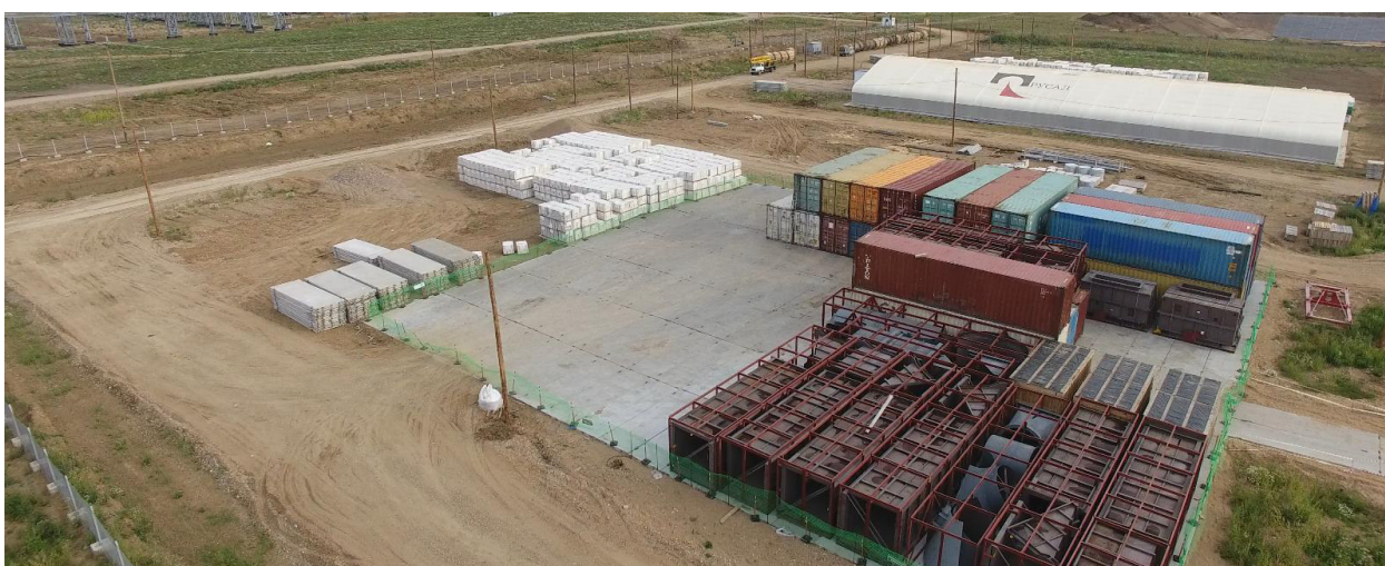
Рисунок 1.1-4. Реализация первого этапа строительства Тайшетской Анодной фабрики. Складское хозяйство
