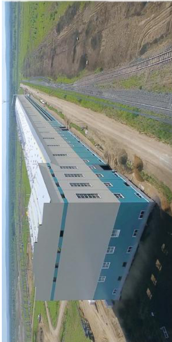
Строительство Корпуса обжига № 1 Тайшетской Анодной фабрики
