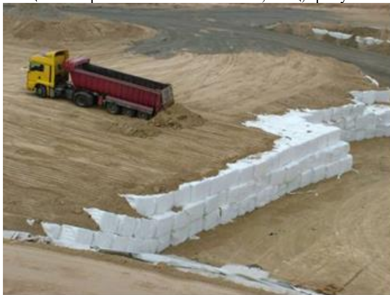
Рисунок 1.1.4 - Процесс складирования ТКО методом поярусного размещения в кипах.
