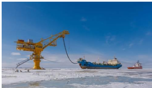
Рисунок 2.3. Выносное причальное устройство (ВПУ) в районе мыса Каменный
