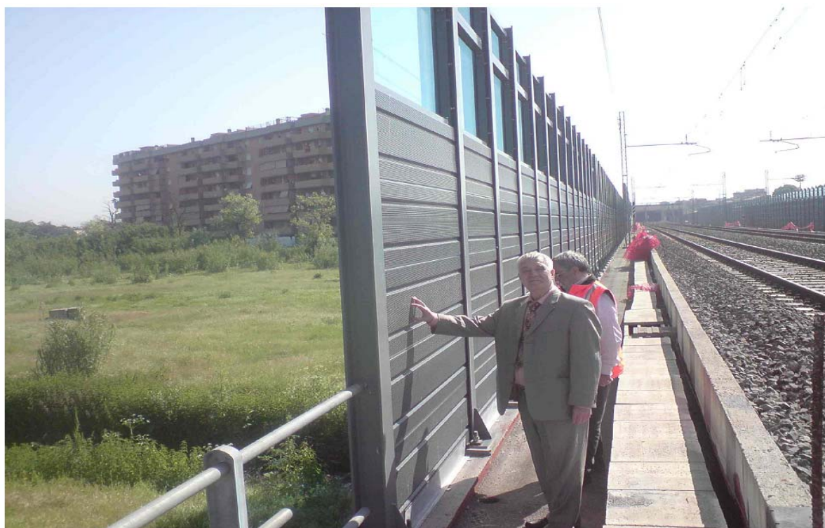
Рисунок 4.5 - Металлический шумозащитный экран
