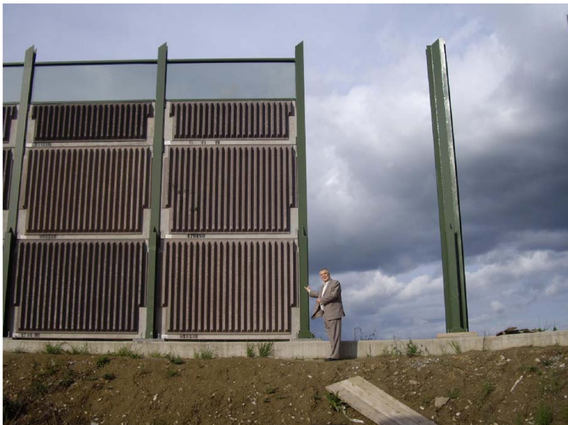
Рисунок 4.4 - Бетонный шумозащитный экран
