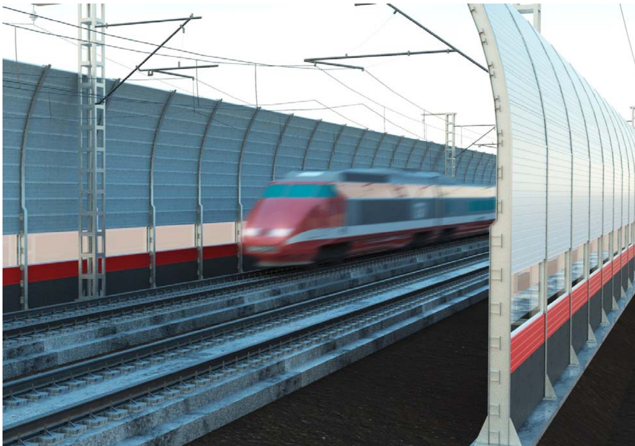
Рисунок 4.6 - Парусообразный шумозащитный экран из стали
