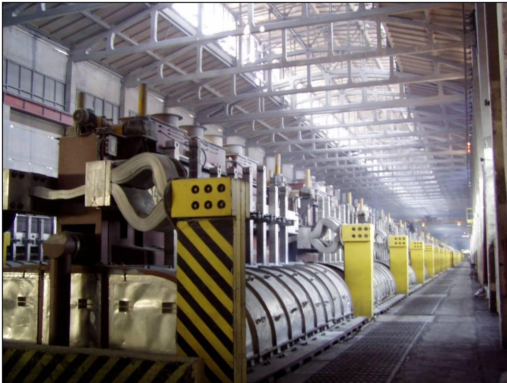
Рисунок 5.2.1.1-2. Электролизный цех на примере Саянского алюминиевого завода
