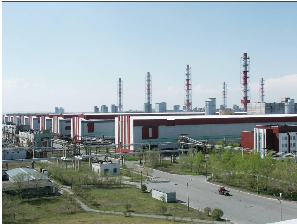
Рисунок 5.2.1.1-1. Корпуса электролиза на примере Саянского алюминиевого завода
