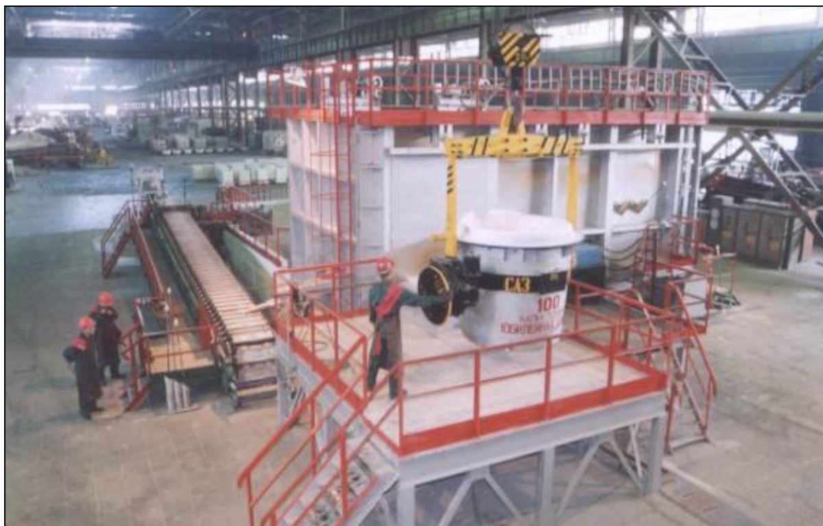
Рисунок 5.2.1.2-1. Общий вид литейного цеха
