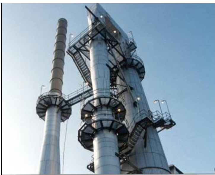
Рисунок 5.1.1.8-3. Охладитель ГОУ печей обжига анодов
