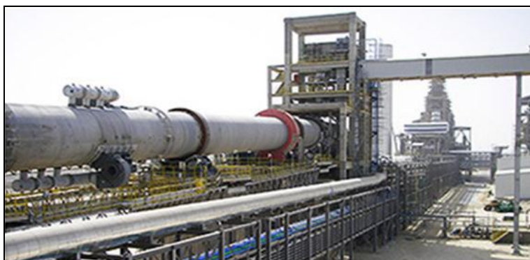
Рисунок 5.1.1.2-1. Печь прокали кокса; холодильник; камера дожигания: фирма FL-Smith (Канада)
