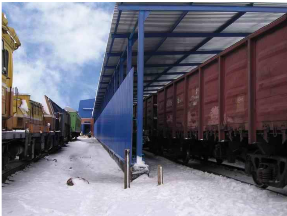
Рисунок 3.1-3. Размораживающее устройство на 5 вагонов
