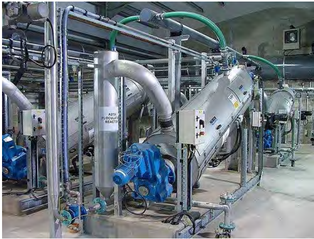
Шнековый пресс для обезвоживания осадка HUBER ROTAMAT® RoS 3
